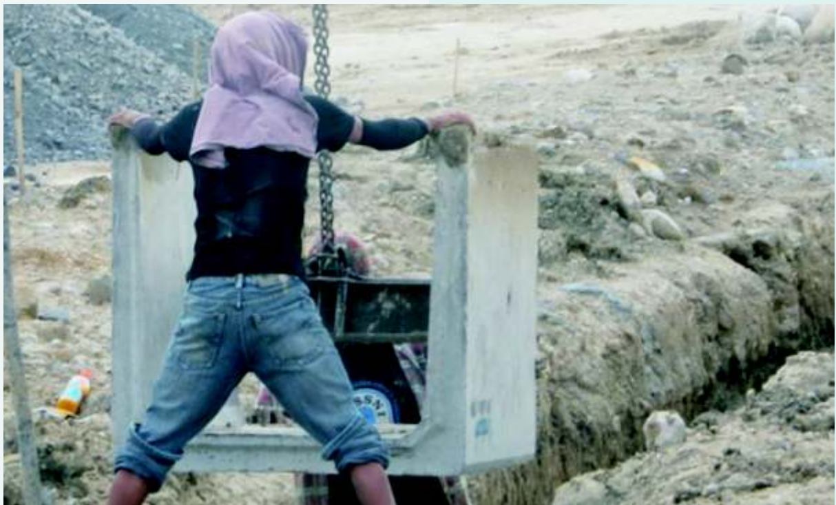
foto ilustrasi: proses pemasangan uditch /sumber: INTICON
